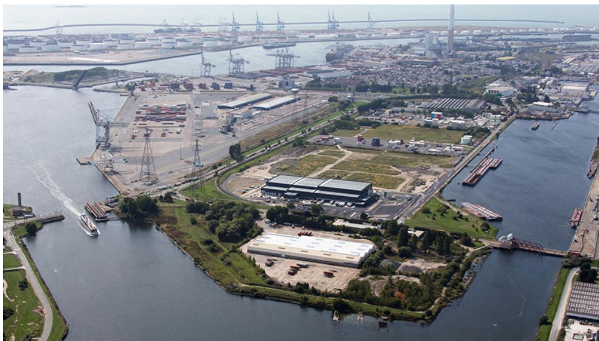
Plateforme Logistique Seafrigo Le Havre – Crédit photo Antoine Vulliez – Septembre 2020
