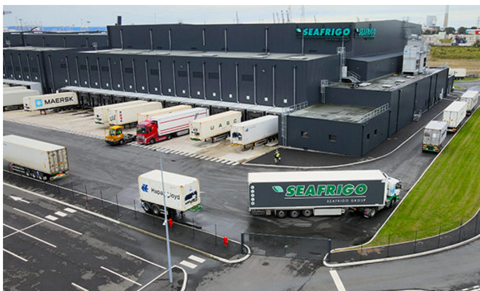
Parc logistique Seafrigo. © Seafrigo
